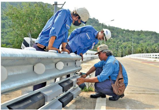
การ์ดเรล (Guardrail) คือ ราวกันตก เป็นอุปกรณ์ป้องกันการตกหล่นสำหรับ ทางสัญจรบนถนนบริเวณทางโค้ง หรือถนนที่เกิด อุบัติเหตุบ่อย ซึ่งจะติดตั้งเป็นการชั่วคราว และยึดติด กับโครงสร้างที่มีความแข็งแรงตามมาตรฐาน ภายใต้ การออกแบบ ติดตั้ง และควบคุมดูแลโดยวิศวกร ราวกันตกต้นแบบสำหรับรถจักรยานยนต์ กรม
