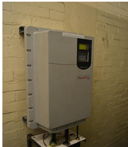
รูปแสดง อุปกรณ์ VSD ของ Cooling Circuit 1
