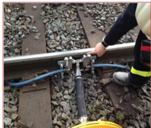
รูปแสดง Rail Grease Unit
