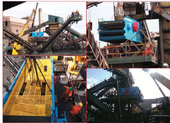
รูปแสดงการติดตั้งเครื่องคัดกรอง Coke
