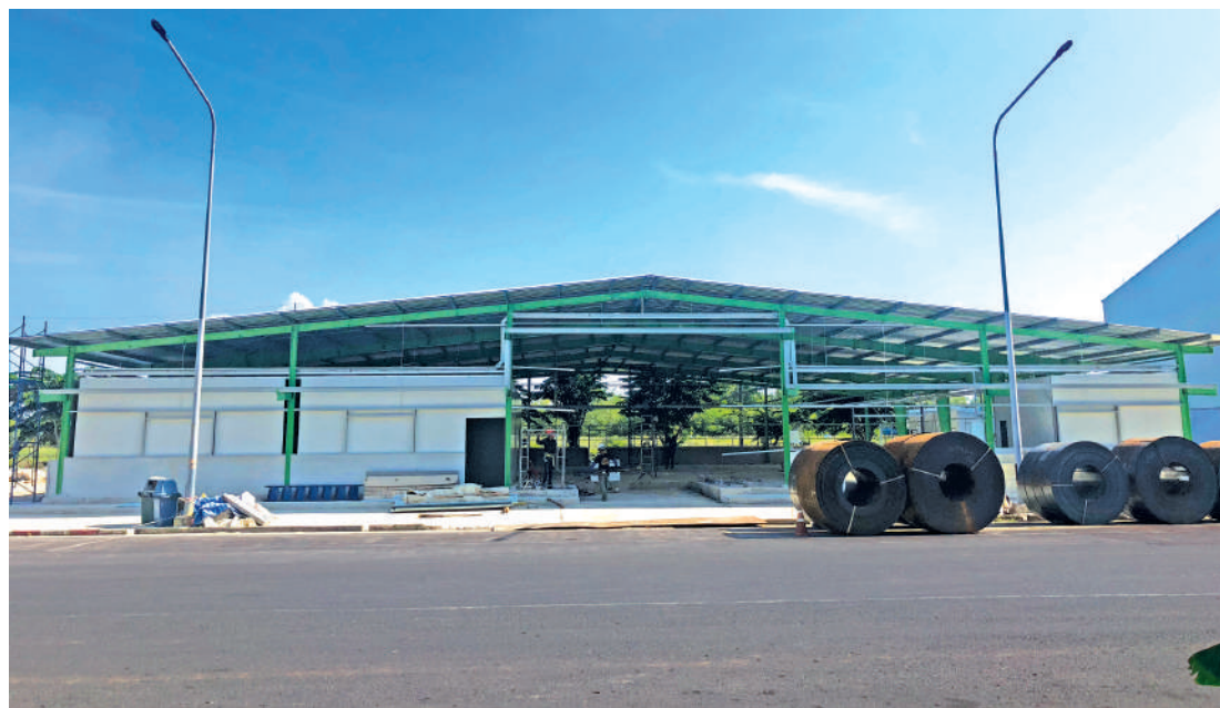
การก่อสร้างอาคารคลังสินค้า (SPC Warehouse) ด้วยระบบโครงสร้างอาคารเหล็กสำเร็จรูป (Pre-Engineered Buildings: PEB) ของบริษัท เวสต์โคสต์เอ็นจิเนียริง จำกัด หรือ WCE โดยใช้เหล็กที่มีกำลังรับแรงดึงสูง Air Beam Technology ของเอสเอสไอผลิต เป็นโครงสร้างชั้นส่วน พร้อมกับขนส่ง ประกอบติดตั้ง ณ บริษัท เหล็กแผ่นรีดเย็นไทย จำกัด (มหาชน) มูลค่างาน 8.6 ล้านบาท
