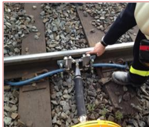
รูปแสดง Rail Grease Unit
